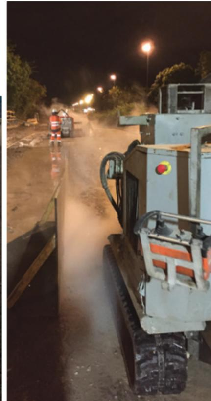
En août dernier, une mission de THP sur le pont de la Beaujoire en région Nantaise, dans le cadre de réfection de longrines de dispositifs de retenue, a permis une récupération des eaux efficace au niveaux des deux culées de l'ouvrage, et un traitement des eaux par décantation et adjonction de CO<sub>2</sub> gazeux, par le mandataire. Au total, plus de 38 m<sup>3</sup> de béton a été hydrodémoli avec deux pompes UHP de 700 cv délivrant 2200 bar et 122 l/min.
